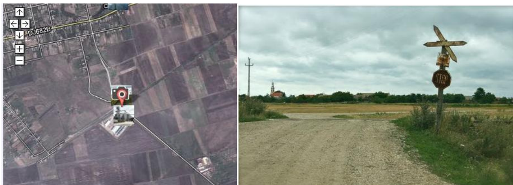
Fig. nr. 33. Trecere la nivel intr-o stare avansata de degradare - Valcani
