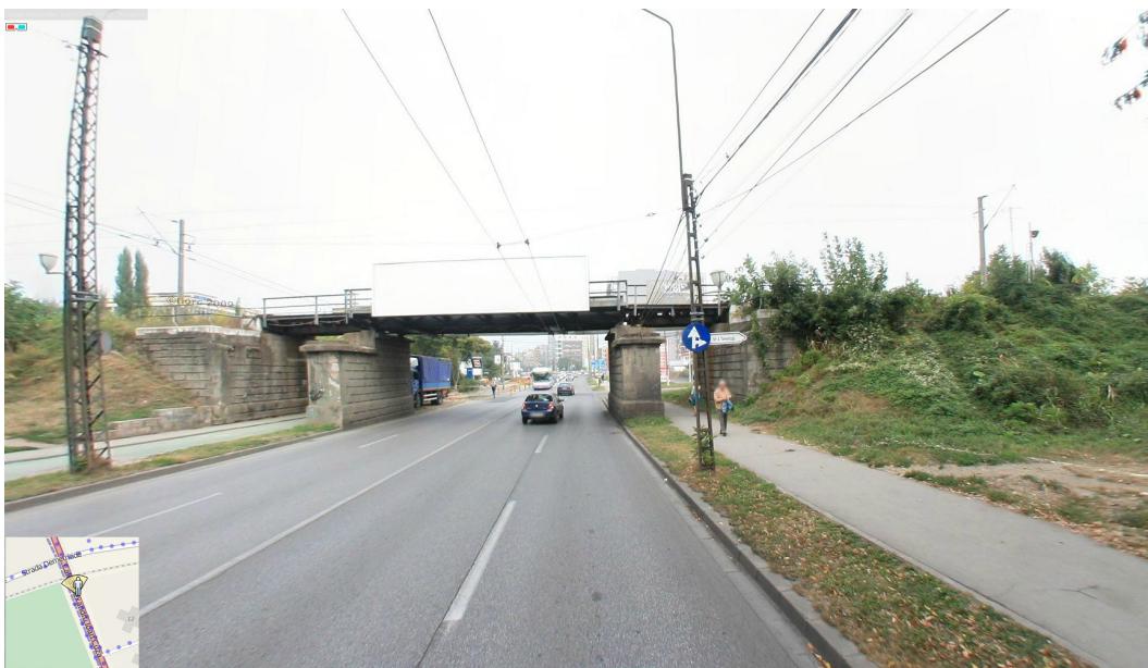
Fig. nr. 37. Subtraversare pe Calea Aradului
